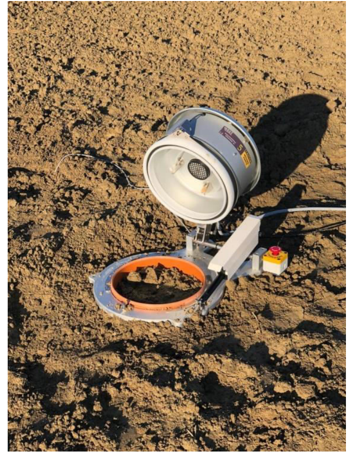
Camera di accumulo aperta
