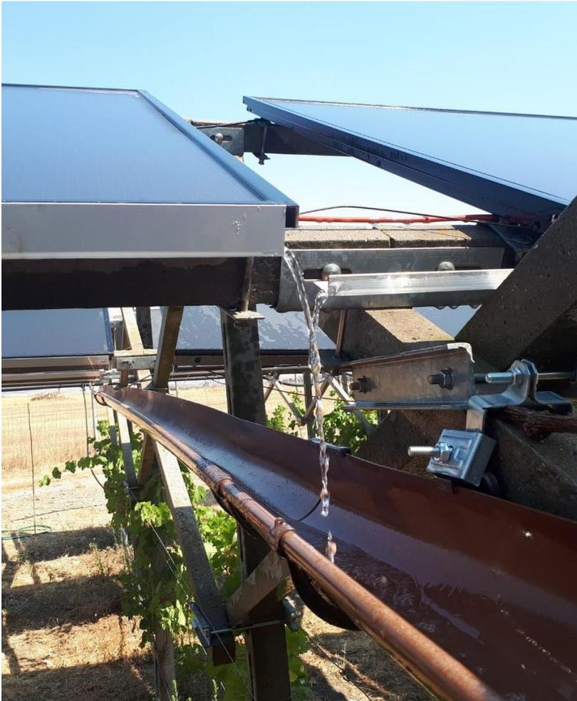
Esempio di pergola agrivoltaica con canalina presso l'azienda SVOLTA
